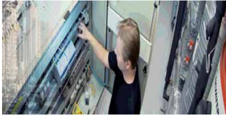
Edificios Existentes. Rehabilitación de Sistemas de Control
